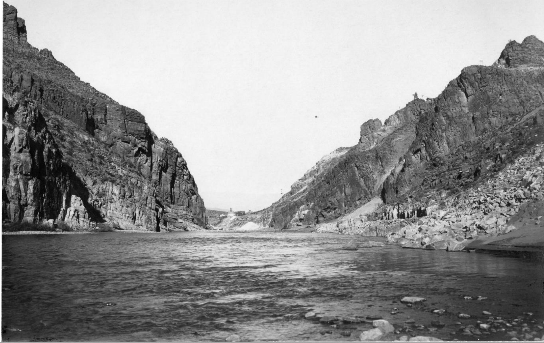
Dam Site (Lubken)
